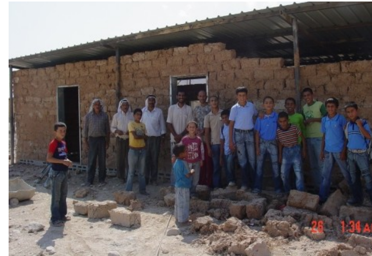
Oben: Die Grundschule von Fasayil im Rohbau. Am 29. November 2007 soll sie von den israelischen Bulldozern zerstört werden. In 40 Jahren Besatzung wurde den Menschen in Fasayil das Recht auf Bildung systematisch verwehrt. Die neue Schule ist die einzige Bildungseinrichtung im Dorf.
